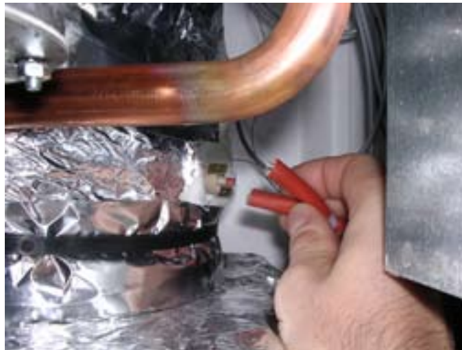
Figuur 2 – Inspectie van de limietthermostaat van de generator
